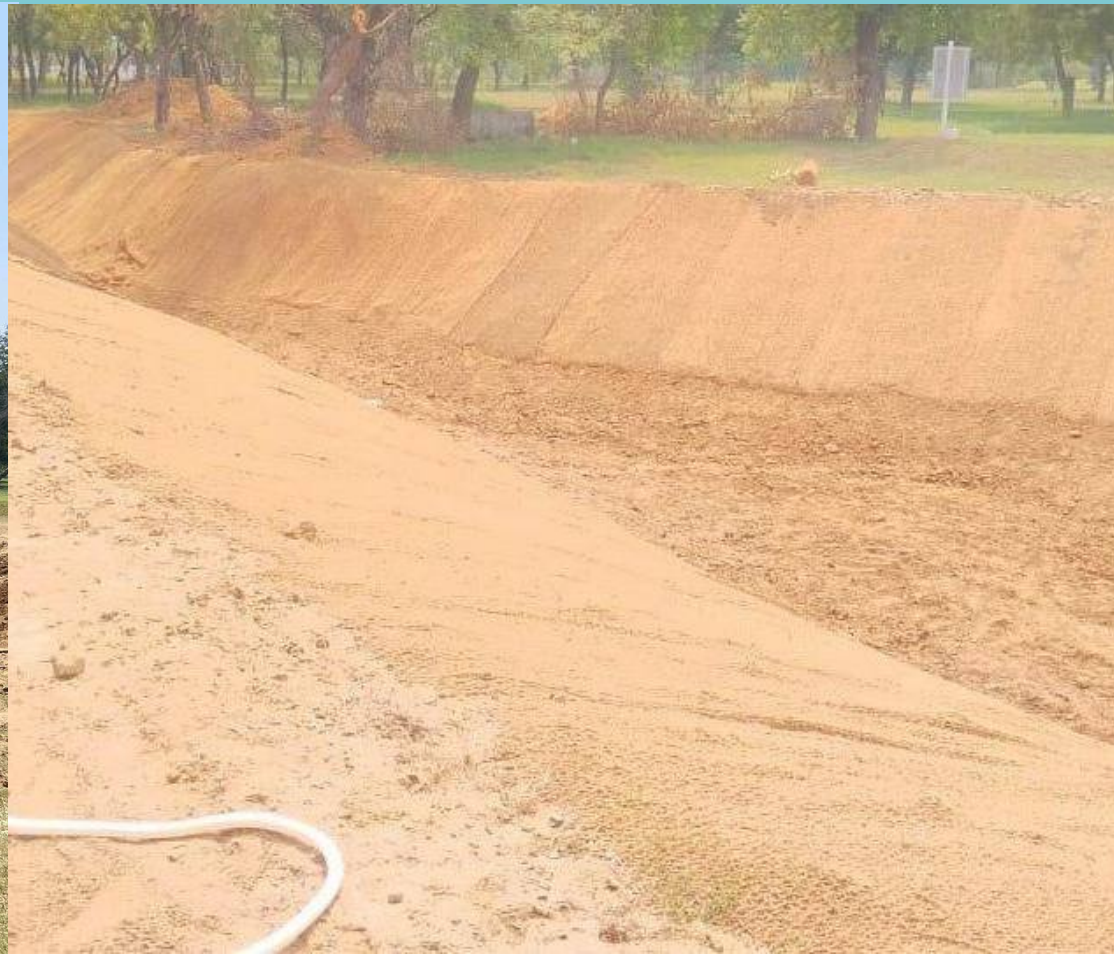
GEO-COIR SLOPE STABILISATION
