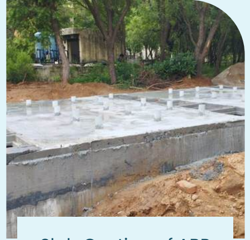
Slab Casting of ABR
